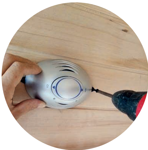
Instalace ionizátoru
