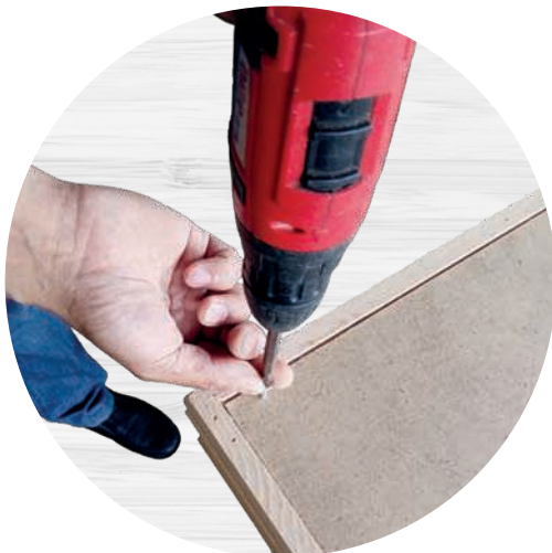
Montáž krytu stropu
